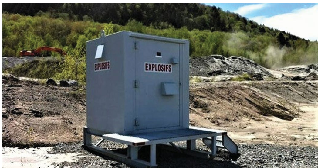
Figure 1 – Dépôt d’explosifs avec panneaux adéquats (source : https://www.bnq.qc.ca/en/standardization/protection-and-safety/magazines-for-industrial-explosives.html ).
